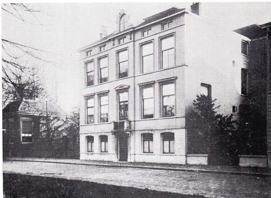
Afb. 38. 1900. Het pand Maliebaan no. 13; aan de linkerzijde de koepel die kort daarna werd afgebroken en vervangen door het monu- mentale gebouw no. 15. Top. atlas Gem. Arch. Utr.
