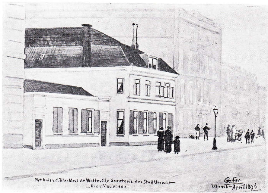
Afb. 28. 1896. Het pand Maliebaan 16. Het werd bewoond door de secretaris der gemeente Utrecht de Wat- teville. Aan de linkerzijde het gewezen lokaal voor godsdienstige bijeen- C. v. Asch van Wijck.
