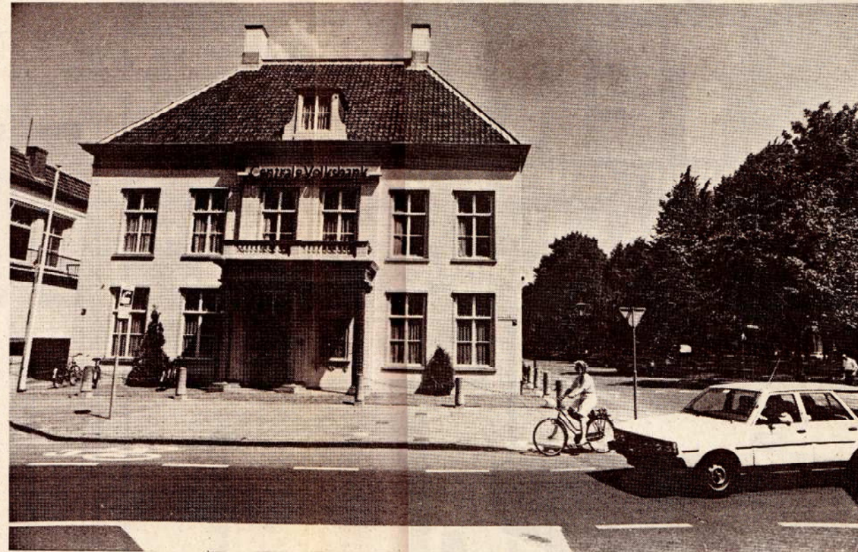
DE CENTRALE VOLKSBANK IS gehuisvest in een voormalig drinklokaal op de hoek van de Maliebaan en de Maliesingel.
