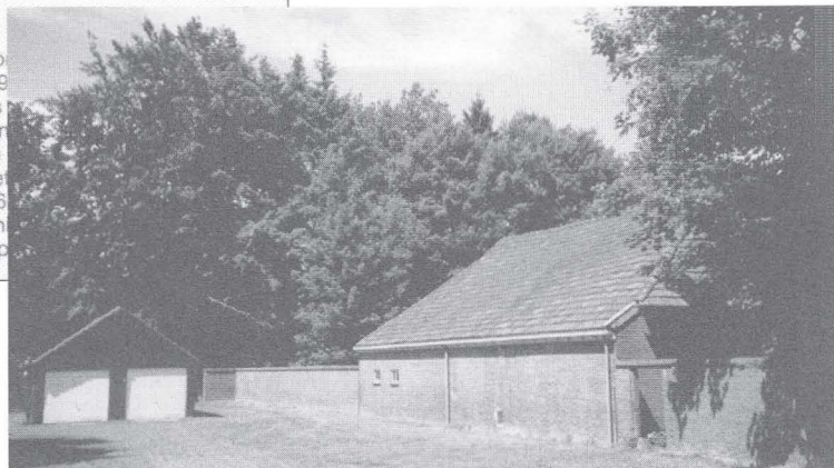
De nieuwe handicartschuur.
