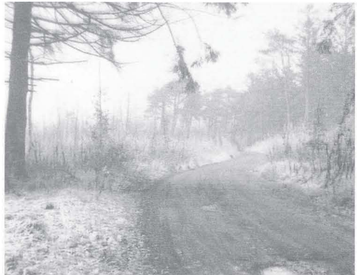
De oorspronkelijke oprijlaan
