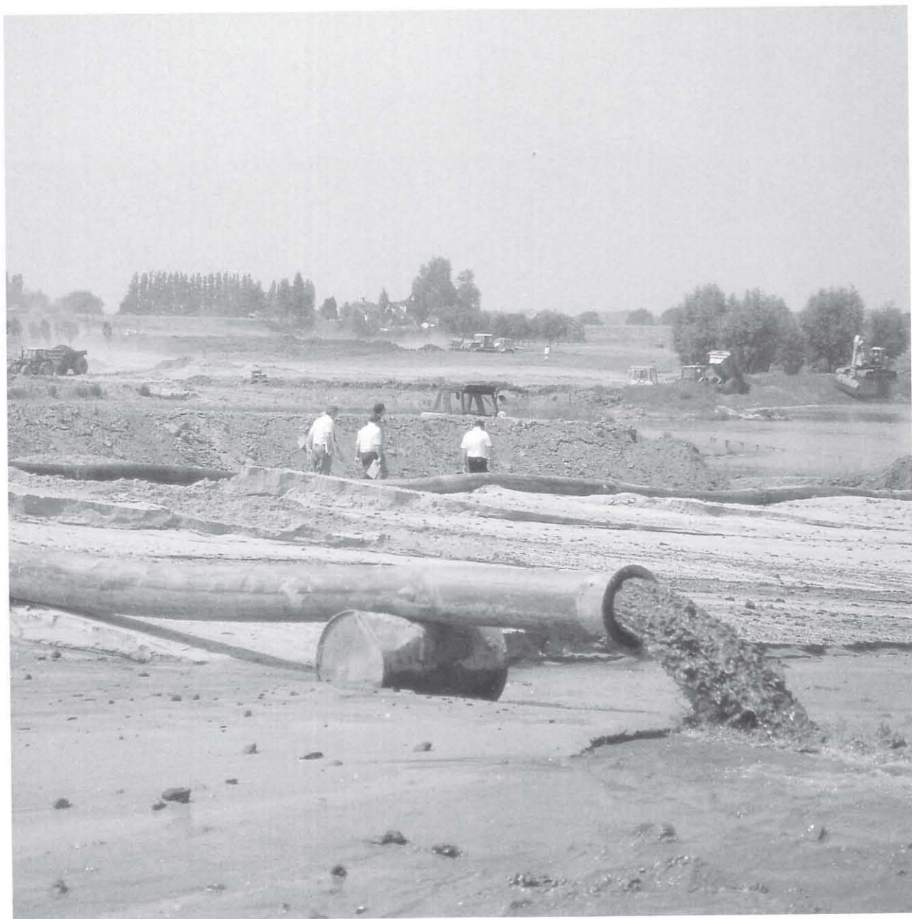
In de eerste fase van de aanleg van een golfbaan moet er in de meeste gevallen veel grond verplaatst worden
