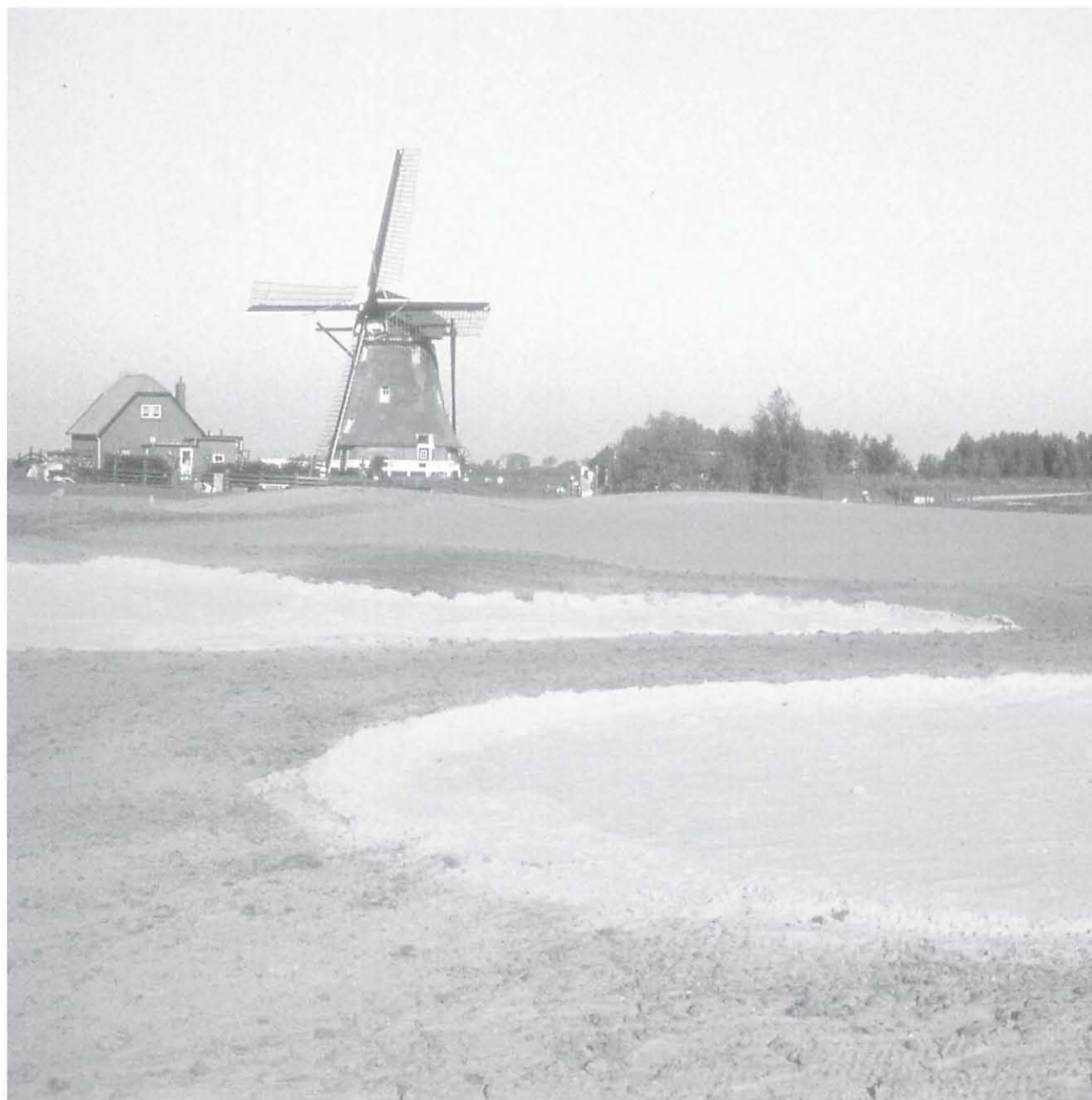
Een golfbaan in aanleg, met een voor buitenlandse bezoekers karakteristiek Hollandse aanblik
