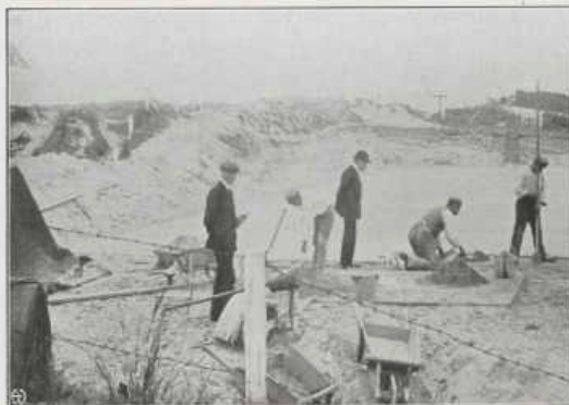
Het aanleggen van een tennisbaan op de Orange Golf Club.
