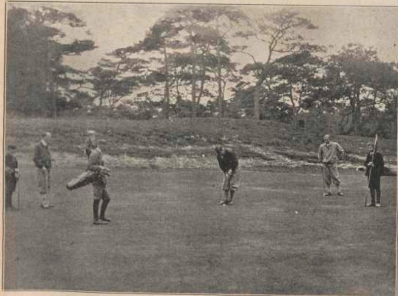
De banen van de Pan liggen in schitterende natuur. Een kijkje tijdens de four-somes op één der fraaie greens.
