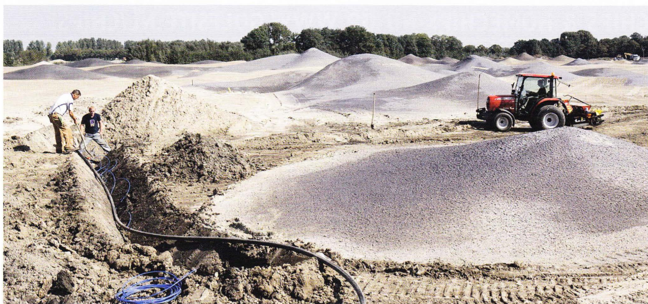
Graafmachines geven de fairway van de par-4 elfde vorm.
